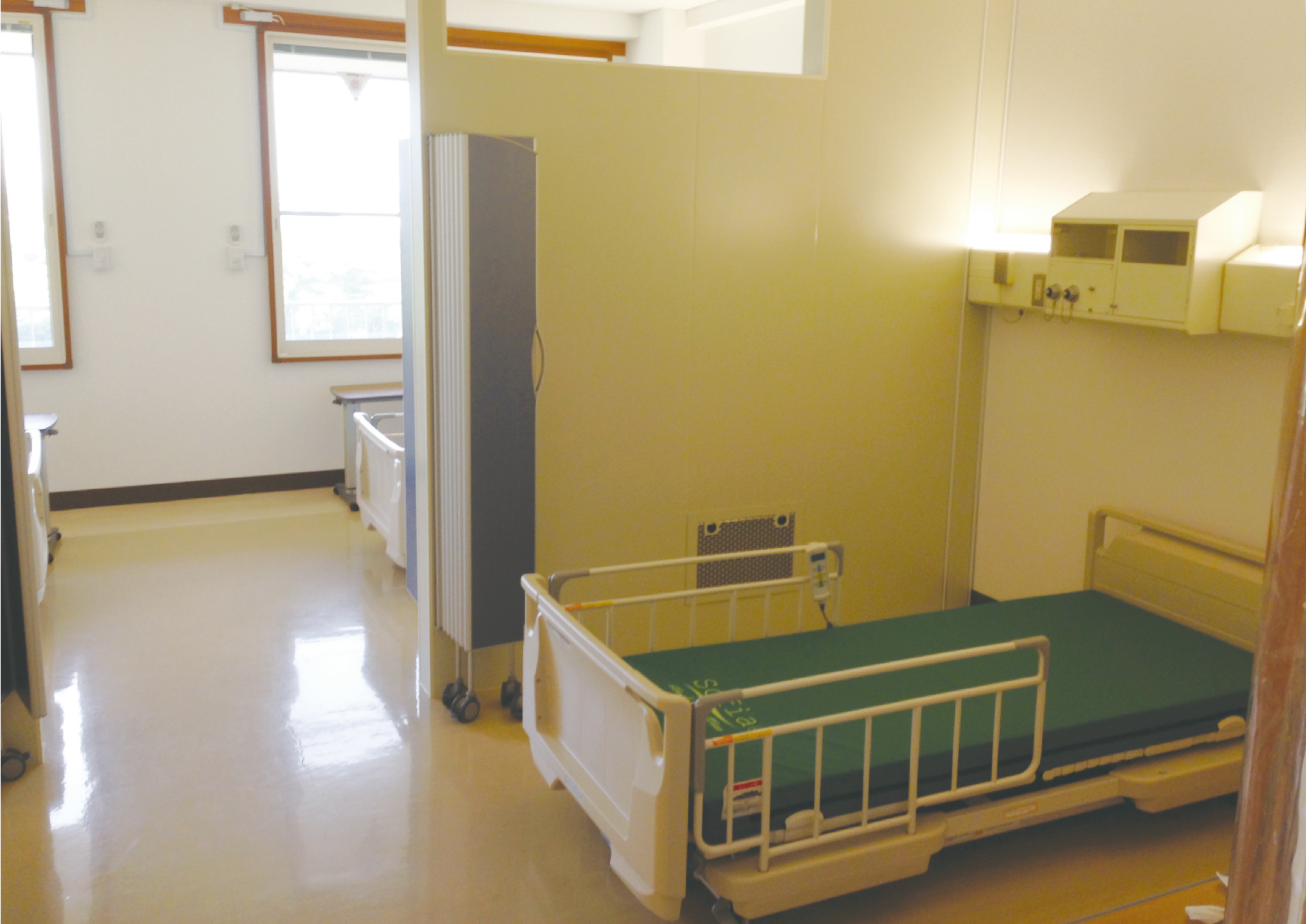
垂直層流型無菌病室ユニット（4床タイプ）内部
